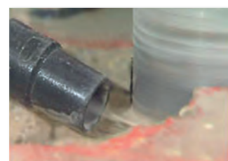
Absaugen des Bohrschlamm
