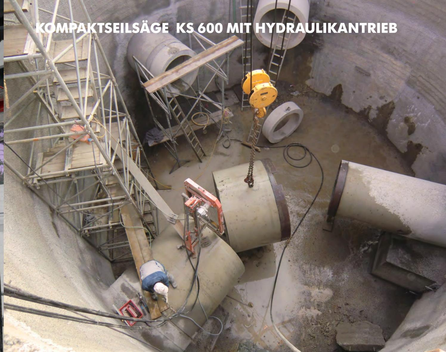
**KOMPAKTSEILSÄGE KS 600 MIT HYDRAULIKANTRIEB**
