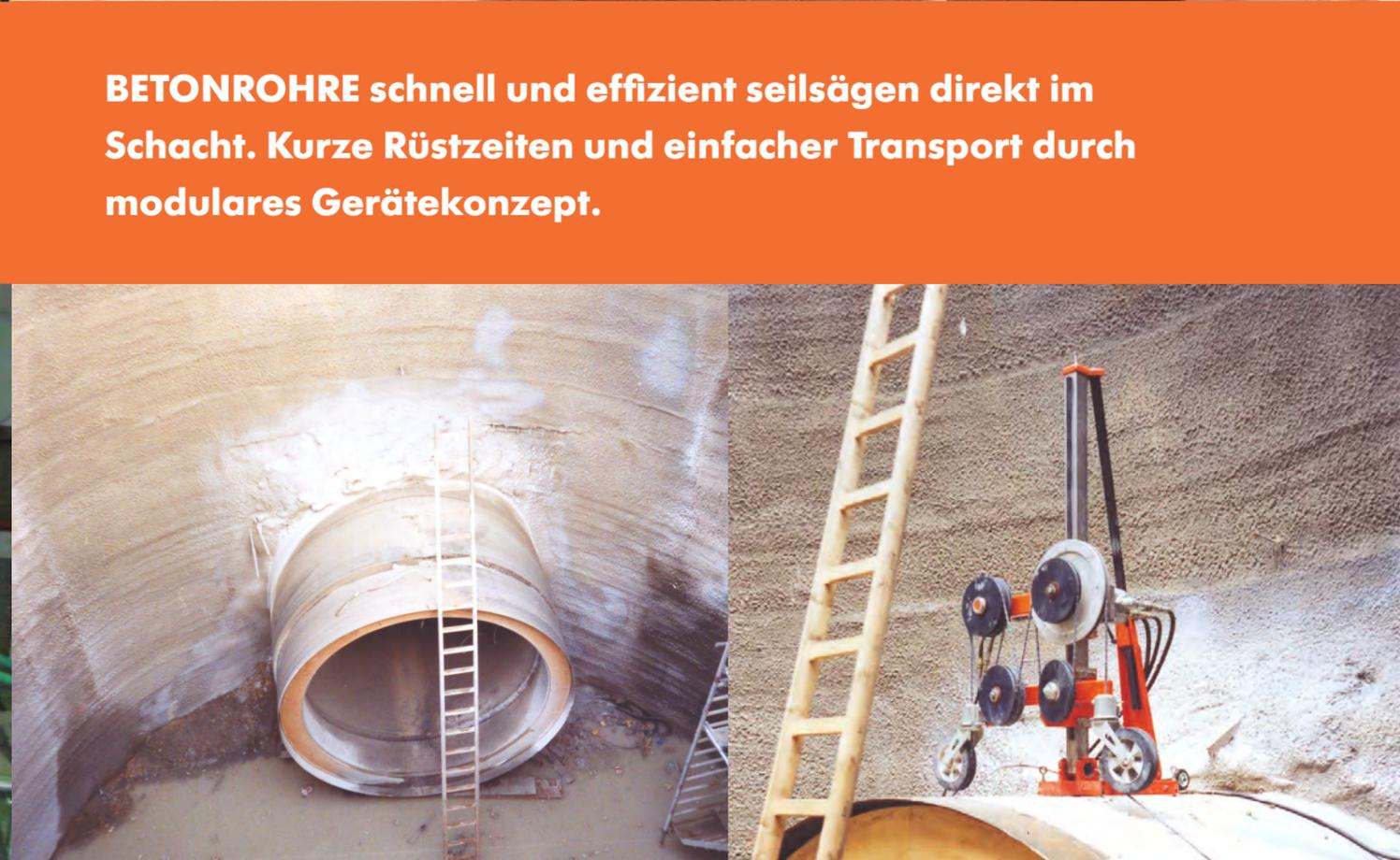
**Seilsägen von Beton mit starker Armierung, trennen von TRESOREN und STAHLPLATTFORMEN**
